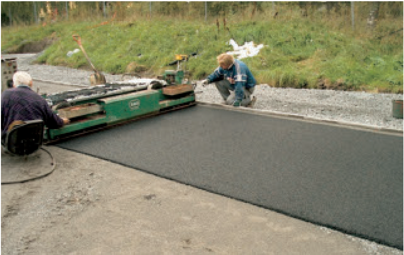
Utlegging av støtdempende sjikt (pad)
